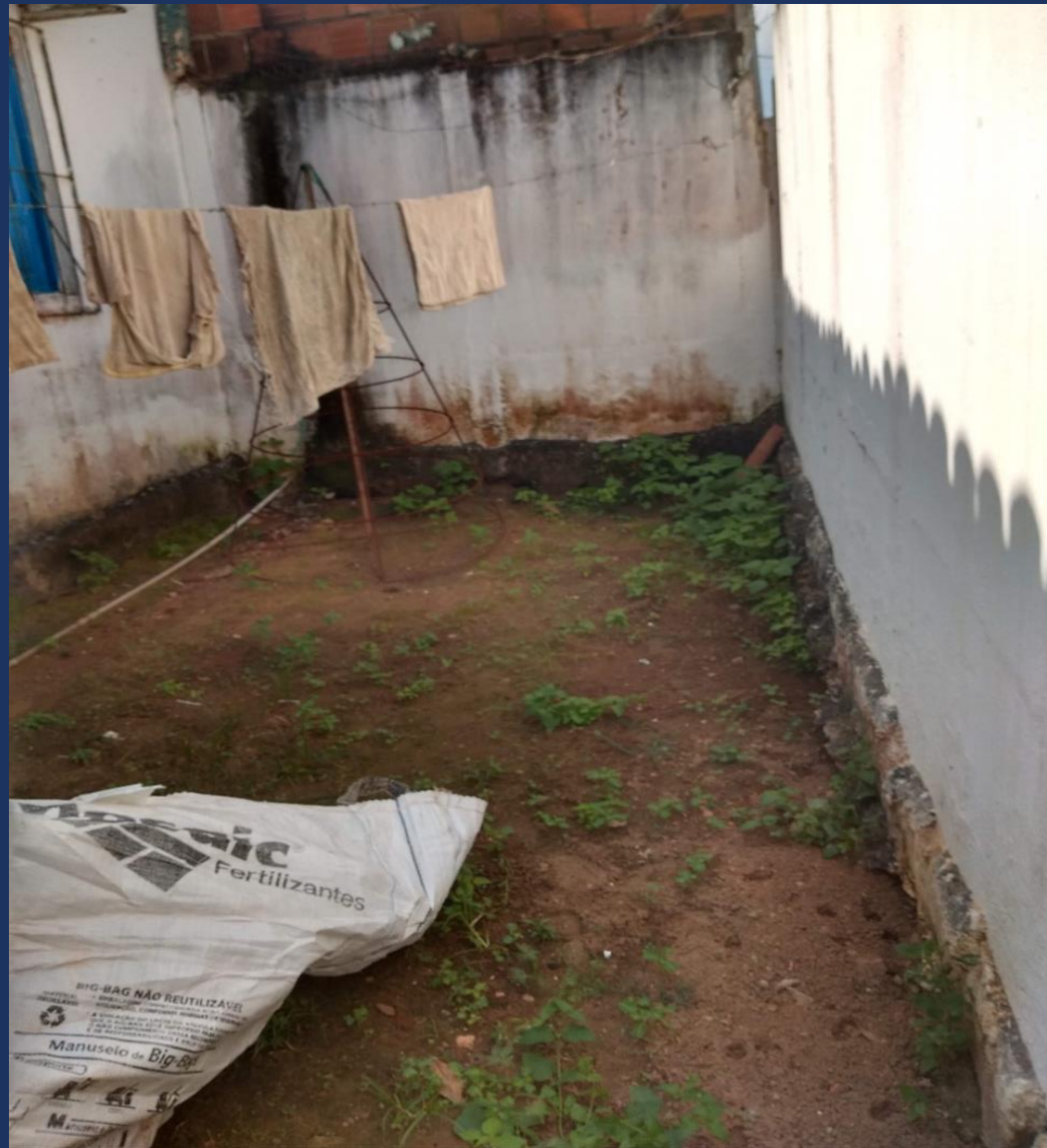
Espaço sem utilização na escola
